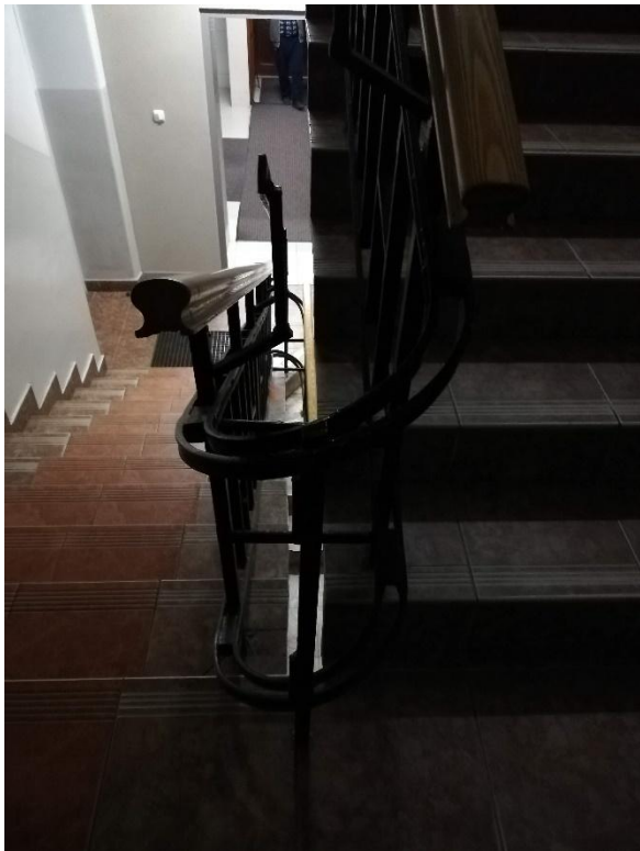
Widok biegu schodowego
