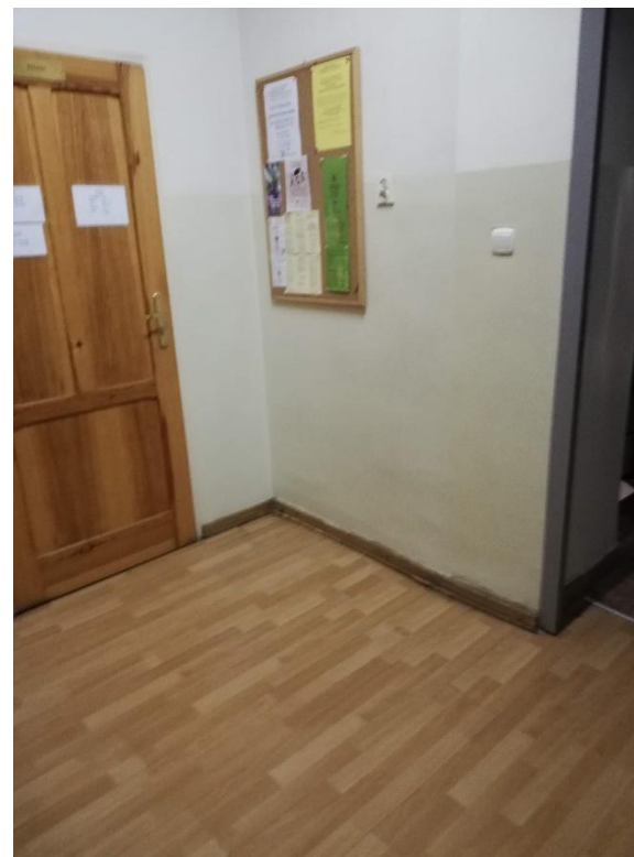
łączenie posadzek korytarz
